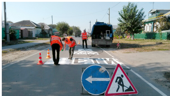
Нанесение разметки на проезжую часть
